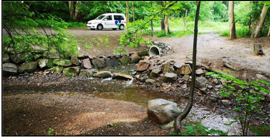
Abb. 5: Mündung des Teichablaufs nach Fertigstellung, 05.06.2020
