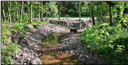
Abb. 7: Erweitertes Abflussprofil zum Schutz des Teichdamms, 08.05.2020
